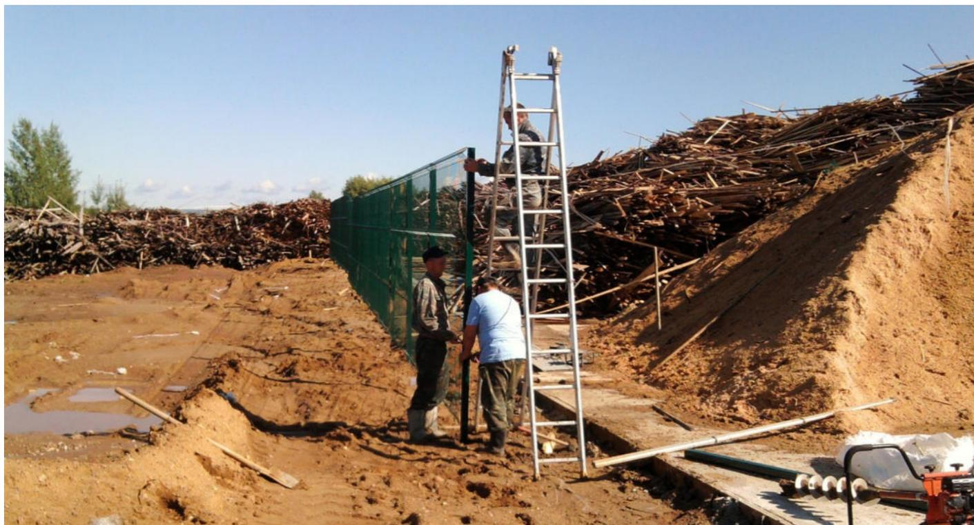
Строительство площадки временного хранения древесных отходов в с. Усть-Кулом – установка ограждения
